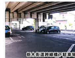
栃木街道跨線橋下駐車場
